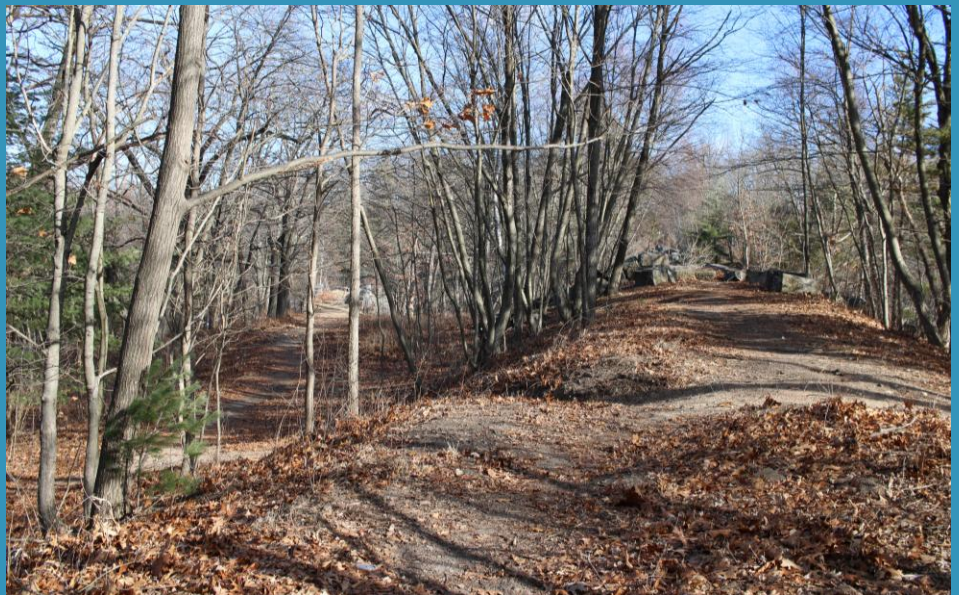
La zona de Indian Leap, con vistas al río desde el antiguo derecho de paso del ferrocarril. A la derecha, en la distancia, se observa el estribo del antiguo puente ferroviario; y a la izquierda, también a lo lejos, el estribo del puente-acueducto.
