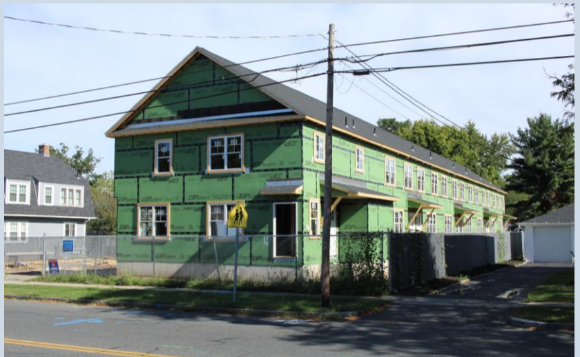
Nuevas viviendas en construcción en la calle Parker, en Indian Orchard
