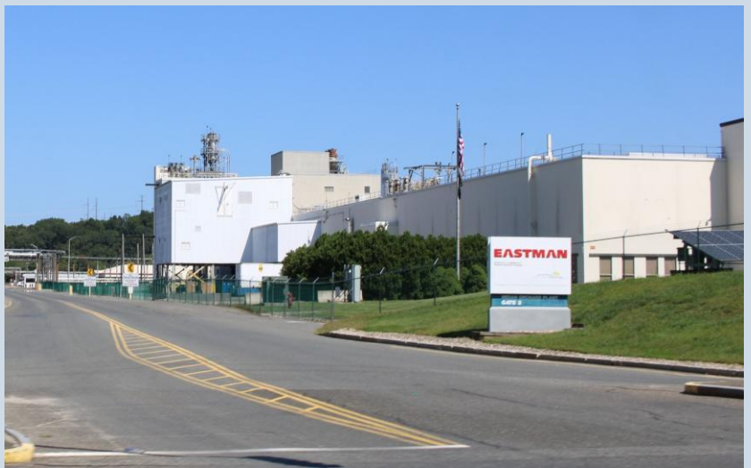
Las instalaciones de Solutia, de uso industrial, en la calle Worcester
