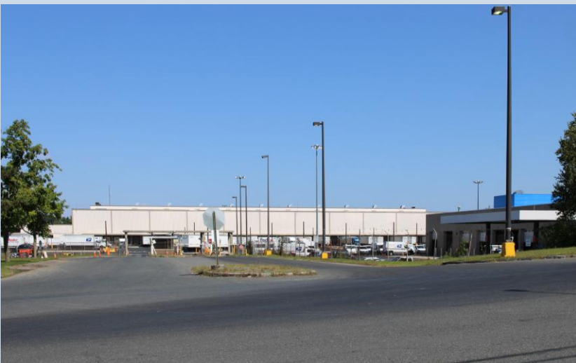
La instalación de procesamiento y distribución del USPS en el bulevar Page
