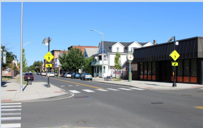
Nuevo cruce peatonal y extensiones de vereda en la calle Main, en la esquina con la calle Pinevale
