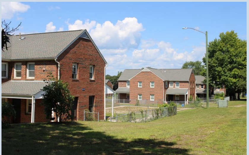
Complejo de apartamentos de la Autoridad de Vivienda de Springfield en la calle Healey
