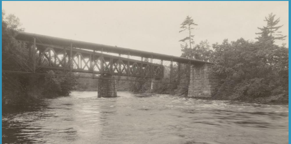
El puente-acueducto y el puente ferroviario sobre el río Chicopee en Indian Leap, vistos desde el lado de Ludlow el 18 de septiembre de 1933. Comisión de Abastecimiento de Agua del Distrito Metropolitano (Metropolitan District Water Supply Commission).
