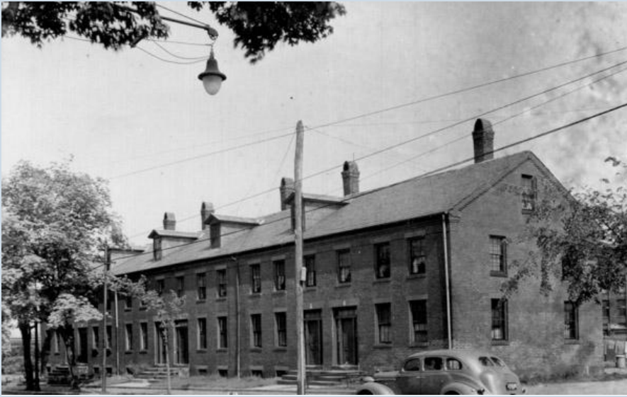
Viviendas colectivas fabriles del siglo XIX en el 114-124 de la calle Main, fotografiadas hacia 1938-1939. Fondo de Preservación de Springfield.
